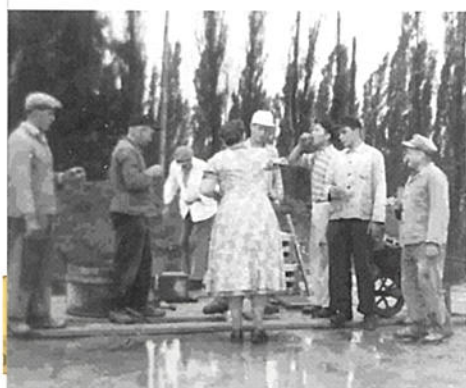
Grundsteinlegung zum Bau der Gaststätte Bienefeld
